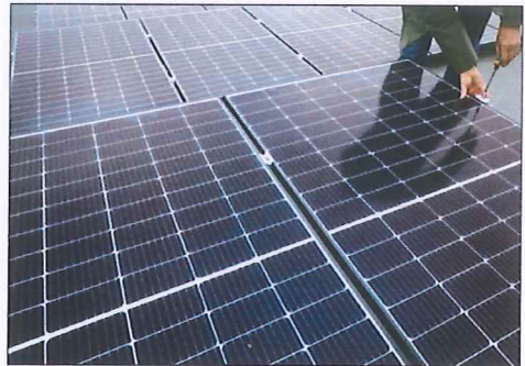
La société ErCiSol (Énergies Renouvelables Citoyennes et Solidaires) est une entreprise coopérative de Foussemagne. Elle installe ici les panneaux solaires (ou photovoltaïques) sur le toit de la nouvelle Maison de Santé de Montbéliard. Photo ER/Lionel VADAM
